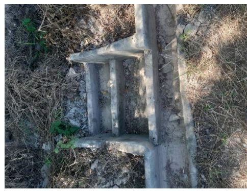
รูปที่ 2-9 บ่อดักคราบน้ำมันบริเวณพื้นที่โครงการ
