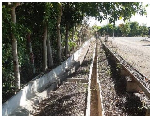
รูปที่ 2-8 รางระบายน้ำโดยรอบบริเวณพื้นที่โครงการ
