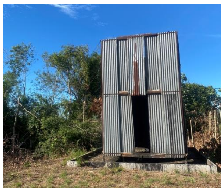
รูปที่ 2-6 กำแพงสังกะสีล้อมรอบปล่องเผาก๊าซ
